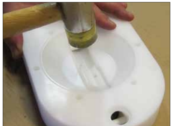
Bild 18. Stellen Sie sicher, dass die Sitze und das Distanzstück flach im Gehäuse sitzen.
